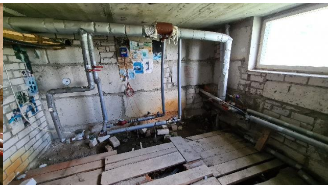
Joonis 2.8. Uus tn 5 soojussõlm
