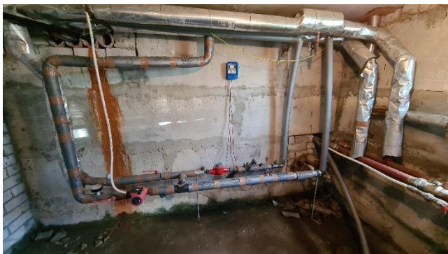
Joonis 2.7. Uus tn 3 soojussõlm
