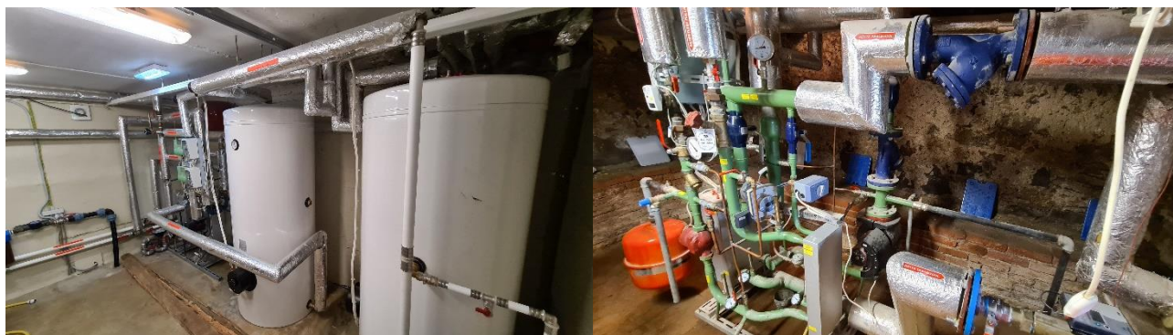
Joonis 2.9. Uus tn 2 soojussõlm
